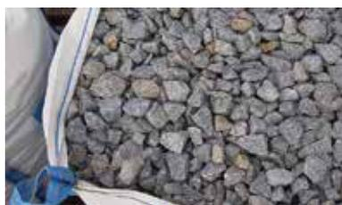
Befindet sich die Baustelle in einer Kleingartensiedlung, wo die Zufahrt mit einem LKW nicht möglich ist, stellen die Big Bags eine saubere und einfache Lösung dar. Nicht nur die Materialanlieferung, sondern auch der Abtransport von Aushub- und Übermaterial ist damit rasch und unkompliziert möglich.
